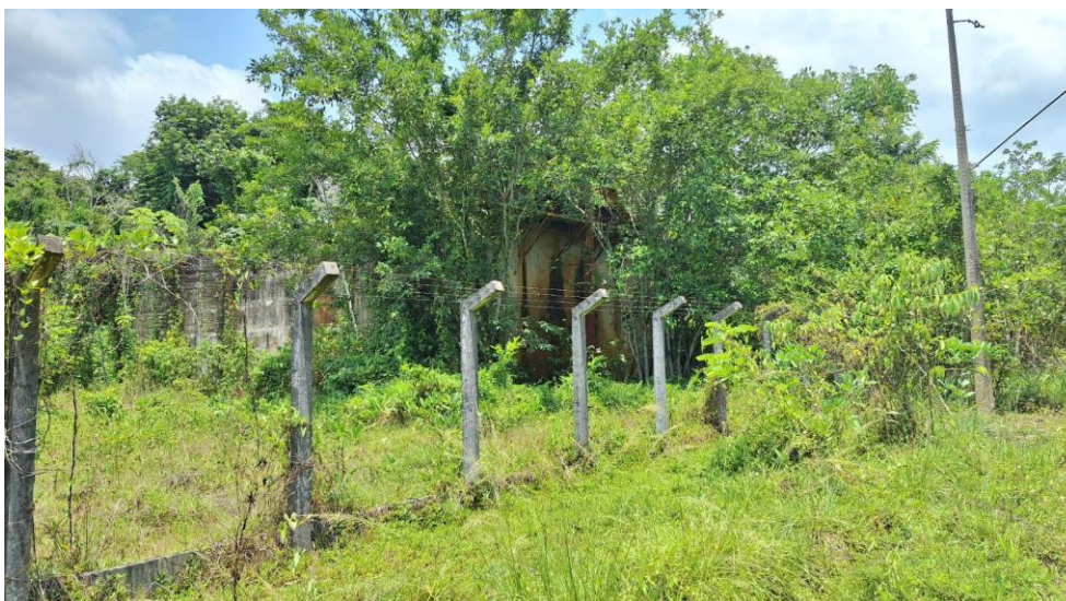
Figura 5 - Prédio da Estação de Tratamento de Esgoto (ETE) da UFPA abandonado
