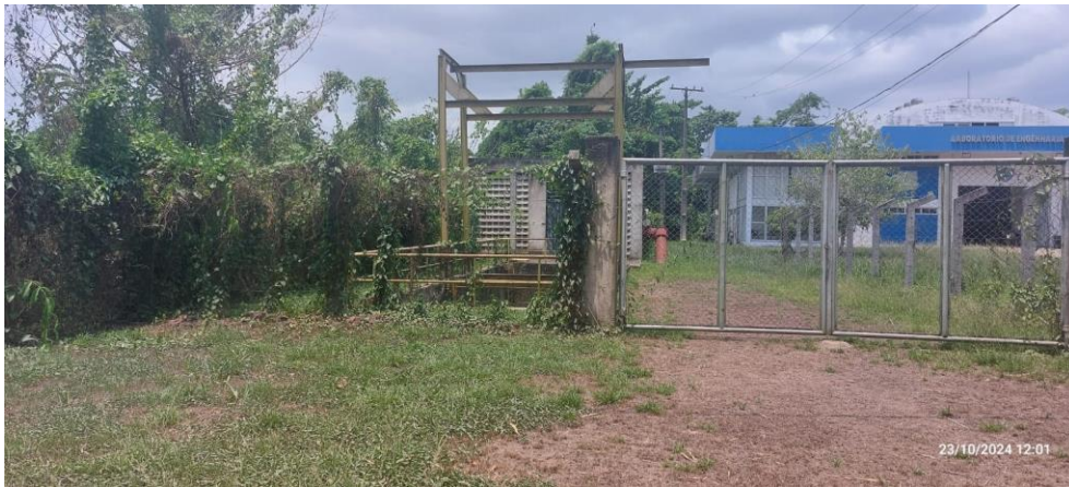
Figura 6 - Equipamento de drenagem de esgoto próximo ao Laboratório de Engenharia Naval da UFPA
